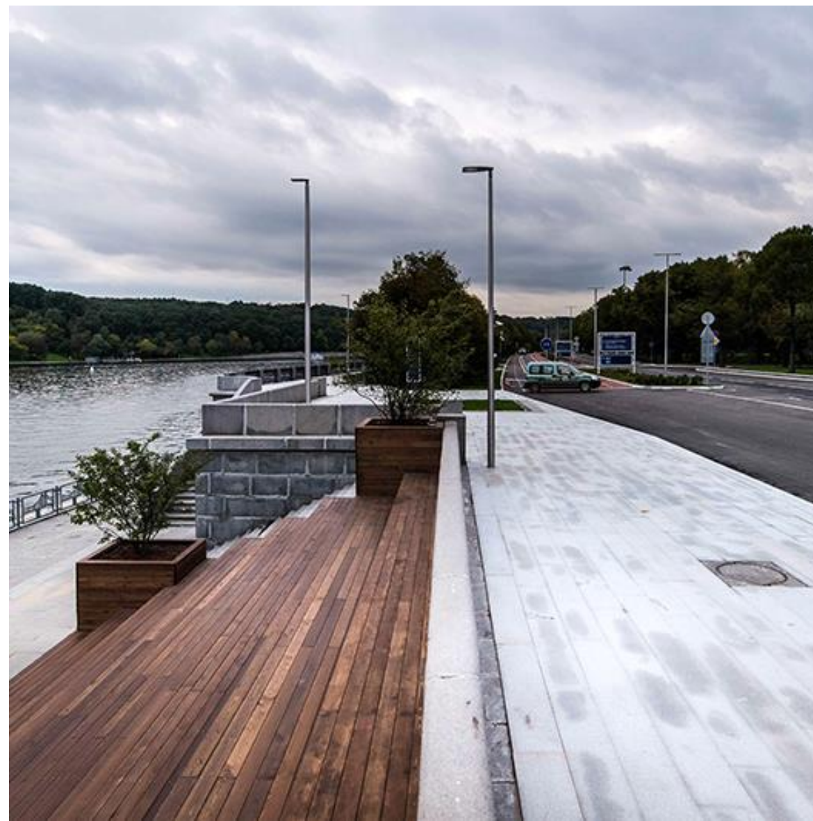
Реконструкция Лужнецкой набережной
