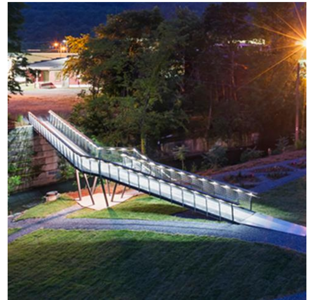
Пешеходный мост Smith Creek Авторы: buildLAB США 2013 (дополняется)
