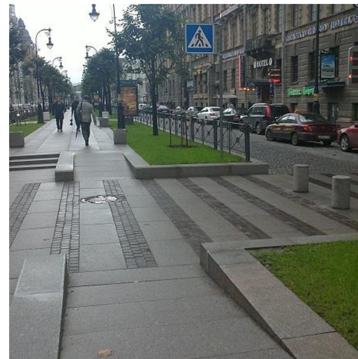
Реконструкция Большой Конюшенной улицы Санкт-Петербург, Россия 2010-2011
